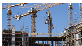
SITIOS EN CONSTRUCCIÓN
